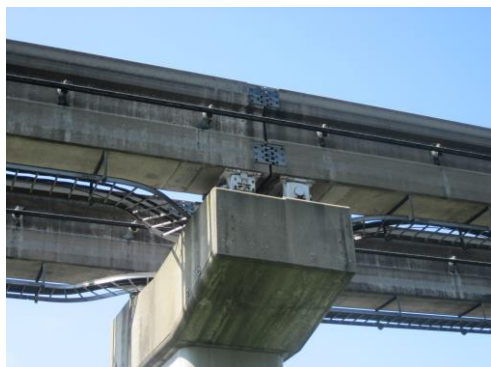
図-8 大阪モノレールのジョイント部分の拡大写真
