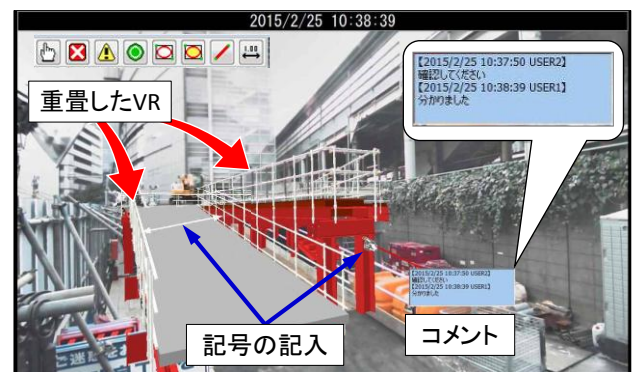
図-10 システムを通じた打合せの状況
