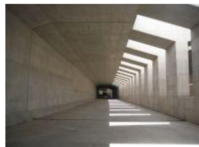
写真-1 矢切函渠その9工事竣工状況
