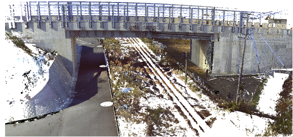
写真-1 対象橋梁の点群表示
