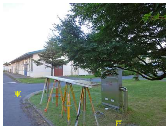
図-7 スライドレールの設置状況
