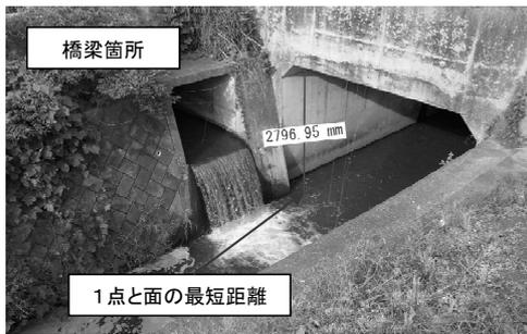
図-9 ステレオ計測の適用例（橋梁部）
