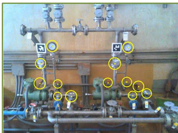
図-2 テンプレート画像と画像上に登録された操作対象
