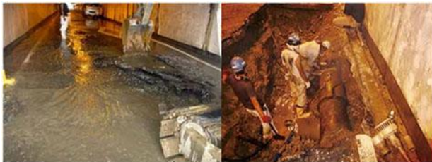
図-1 城山トンネル内の漏水・修理の様子 (海南市水道部広報誌：2012年8月2日)
