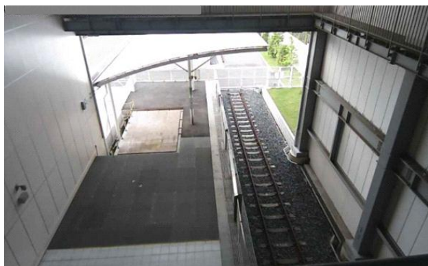
図-5 試験現場の状況
