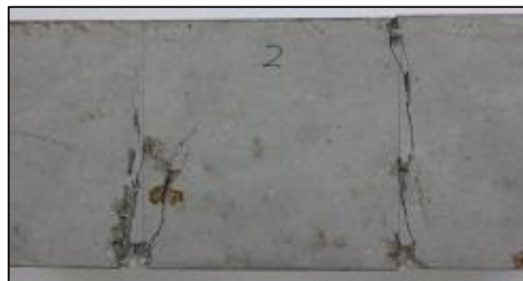
図-2 ひび割れを発生させた供試体
