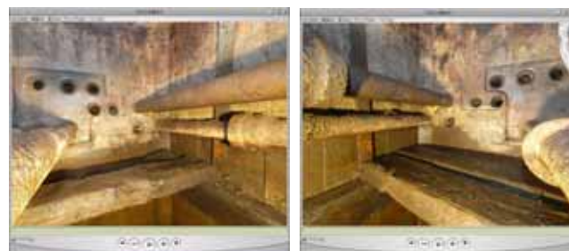
図 - 3 旧規格マンホールの設備点検画像
