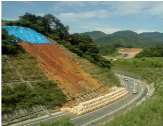
写真-2 早期に実施された仮復旧後例
