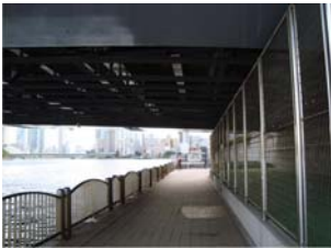
写真-2 桁下空間
