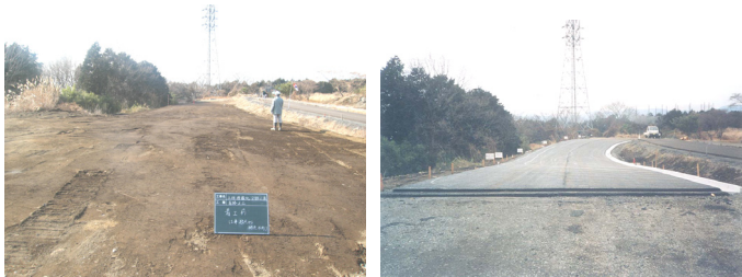
図-8 模擬工事着工前・完成後
