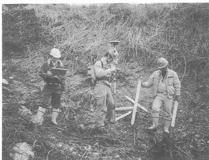
写真-1 位置出し状況
