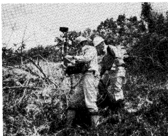
写真-5 測量状況
