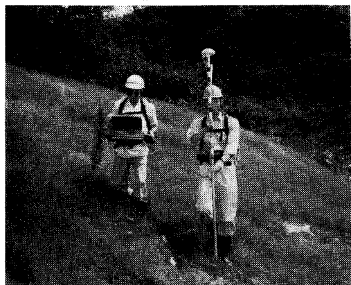
写真-3 横断測量実施状況
