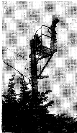
写真-5 モニタリングカメラ
