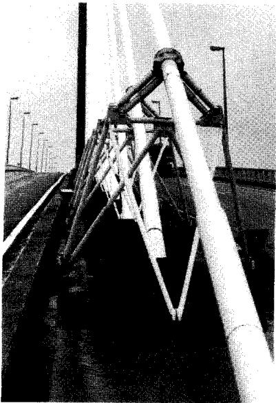
写真－１ ケーブルダンパーの例（プロトンヌ橋）
