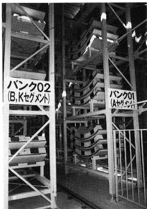
写－１ 自動ストックラック内部
