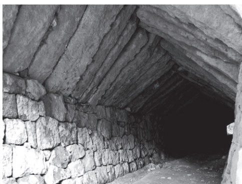
写真-7 川原隧道（撮影：馬場俊介）
