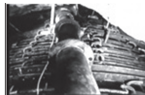
写真24 コンクリートポンプ配管 (F06 32:23)
