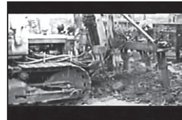
写真51 バイブルドーザ (F18 26:15)
