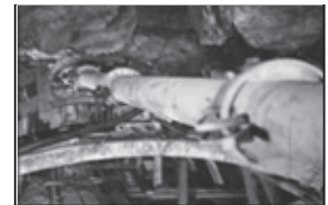
写真32 コンクリートポンプ配管 (F13 16:28)
