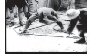
写真60 クーリングパイプ加工 (F02 6:05)
