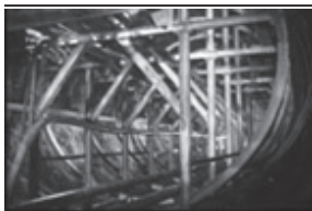
写真25 鋼製セントル (F13 15:23)
