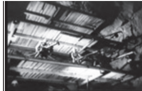
写真2 ジャンボによる掘削 (F05 19:30)
