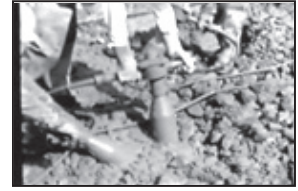
写真44 電動式パイプレータ (F03 43:37)
