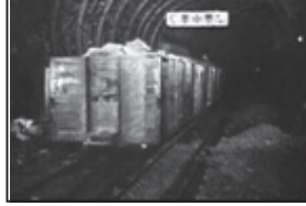
写真10 トロ列車によるズリ搬出 (F12 29:35)
