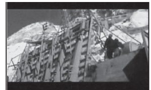
写真56 クレーンによる型枠設置 (F17 18:20)
