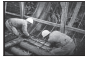
写真27 型枠固定 (F13 15:35)
