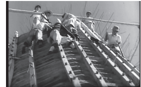
写真52 型枠固定作業 (F01 13:50)
