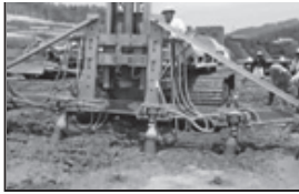
写真49 バイブルドーザ (F10 22:58)
