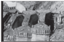
写真53 中空重力式堤体打設 (F03 52:32)
