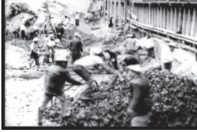
写真41 3箇所同時打設 (F02 5:53)
