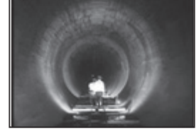
写真16 圧力トンネル完成 (F01 15:12)
