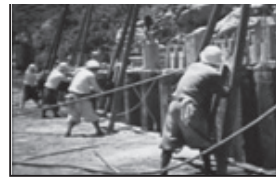
写真55 人力での型枠移動 (F04 54:48)
