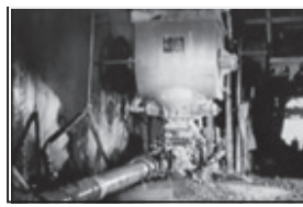
写真23 コンクリートポンプ (F06 32:15)
