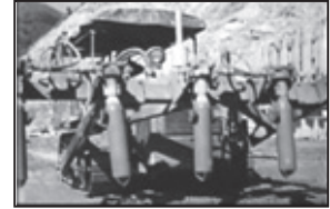
写真48 バイブルドーザ (F13 26:58)
