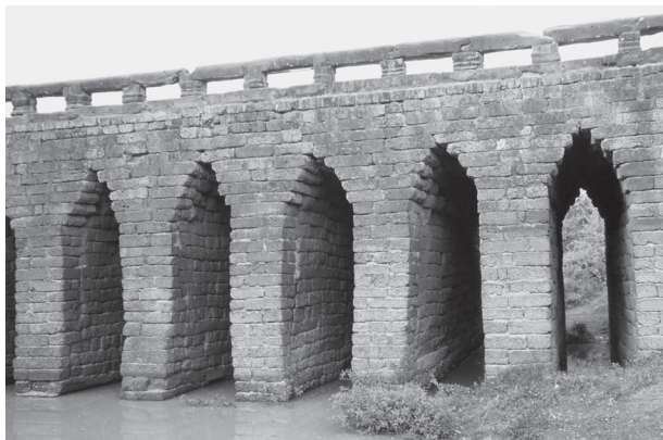
写真-18 スピアン・プラプトゥスの部分形状
