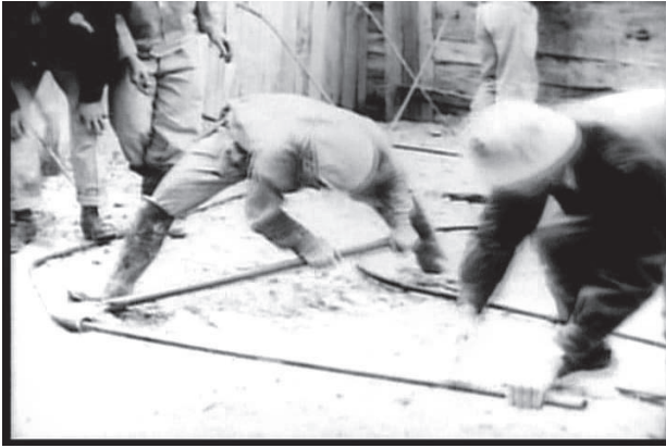
写真1 クーリングパイプの曲げ加工作業 (新理研映画製作所制作「上椎葉水力発電所」より)
