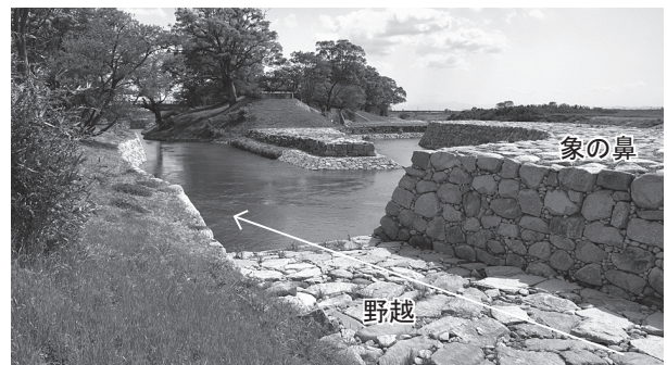
写真-10 復元された象の鼻・野越（撮影：吉村，2006.4）
