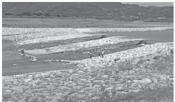
写真-5 新設復元された大井手堰（撮影：吉村，2006.7） *戸立は起伏式ゲートで2カ所に集約されている。ゲート部を除く堰本体は伝統的技法を用いた空石積で施工されている。
