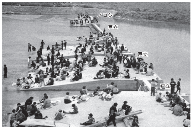
写真-4 昭和30年代の大井手堰（佐賀土地改良区所蔵） *戸立4カ所（写真の手前にもう1カ所ある）。一番奥がノコシ（野越）。
