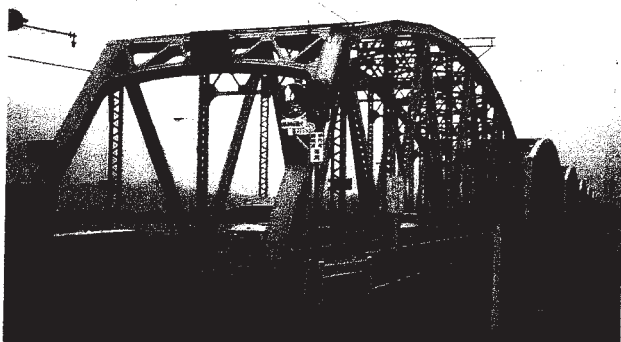
写真-4 吉野川橋の上対傾構
