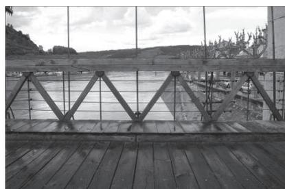
写真-17 トゥルノン橋の補剛桁(撮影:本田)
