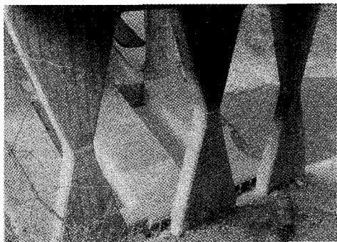
写真-31 坪沢橋鉛直材（撮影：筆者 2001）
