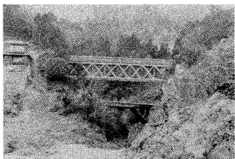
写真-1 川井大橋（下 旧道）と大正橋（上 新道） （1937年頃 東京都建設局蔵）
