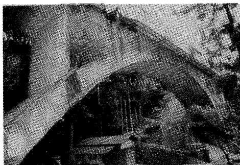
写真-6 川井川橋梁（撮影：筆者 2001）
