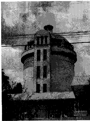
写真-3 野方配水塔
