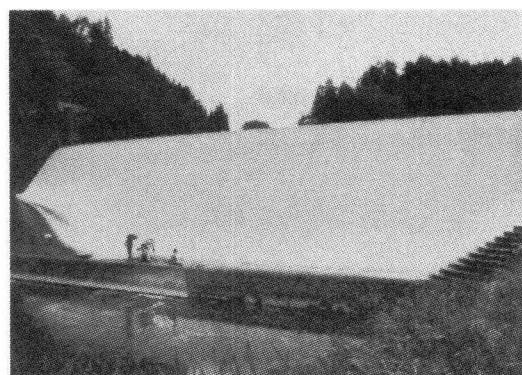
写真1 白水堰堤(撮影:松尾、2003)
