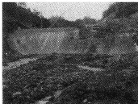
写真8 左岸側堤体の施工の様子
