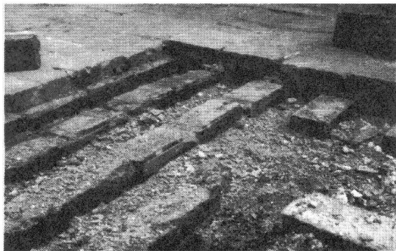
写真-4. 奥平野浄水場のレンガ積(著者 1979.)
