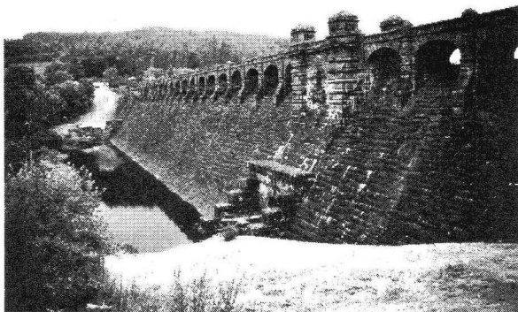
写真-7. Vyrnwy Dam (撮影：著者、2002.7.22)
