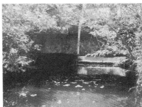
写真-2 芦川橋の現況
