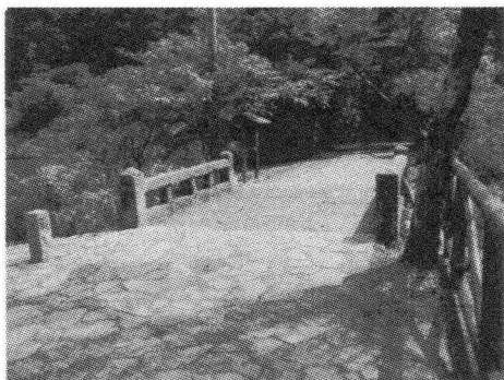
写真-1 芦川橋の現況
