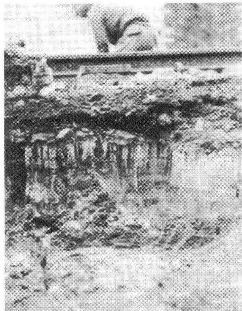
図5 掘削され露出した路盤 注3
