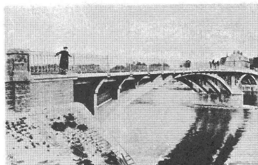
写真-2 ドシズ橋
