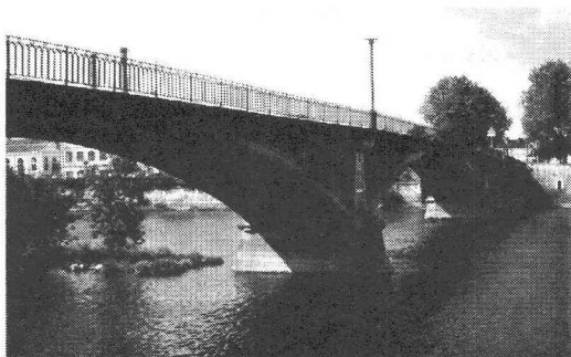
写真-1 シャテルロー橋
