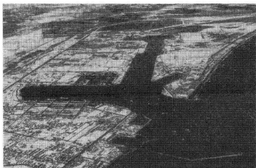
図1 建設途中の苫小牧港西港区の様子
