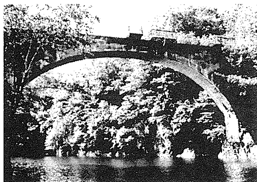
写真3 旧士幌線第三音更川橋梁
