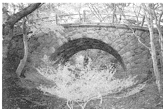
写真－1 函館公園 白川橋 (撮影：進藤義郎)
