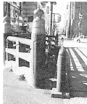
写真－6 創成橋 現在の親柱（撮影：進藤義郎）
