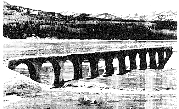
写真1 タウシュベツ川橋梁
