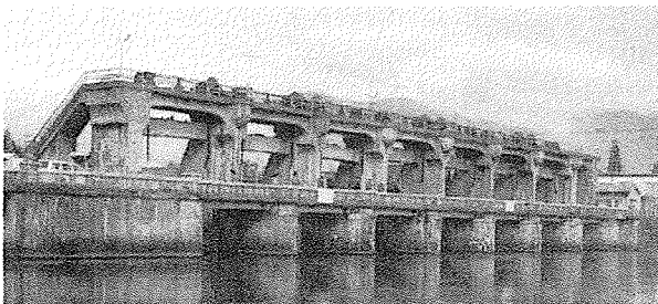
写真-8 昭和53年当時の旧釜口水門。写真をよく見ると、堰柱等に無数のクラック(ひび割れ)が現れている。
