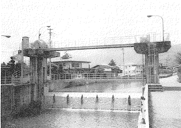
写真-1 「文出大堰」。左岸堰柱の所に昭和24年の水神が祀られている。（撮影：久保田、2000年7月27日）
