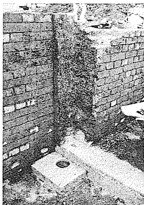
図-6 樋管の軸受け石
