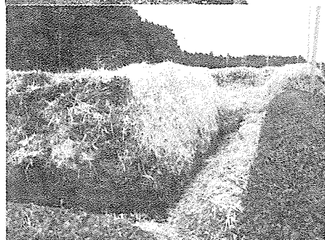
写真-4 A-2中央部を見る (2000)
