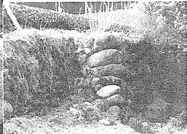
写真-15 A-2の石垣内部の間詰め石 (2002)
