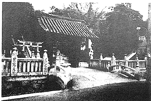
写真 1.2 神社の前の太鼓型をした桁橋 （三門中町の観音寺用水）
