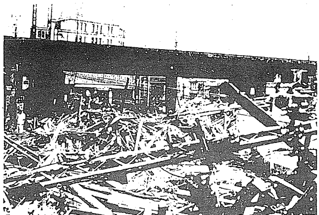
写真-5 長狭橋の橋面上の状況 13)
