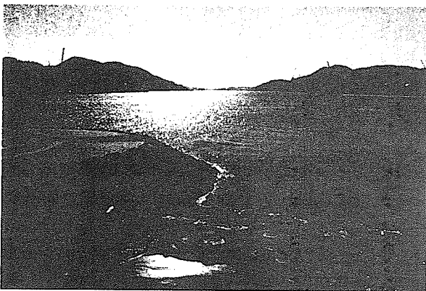
写真-5 水路河口部の潜り堰
