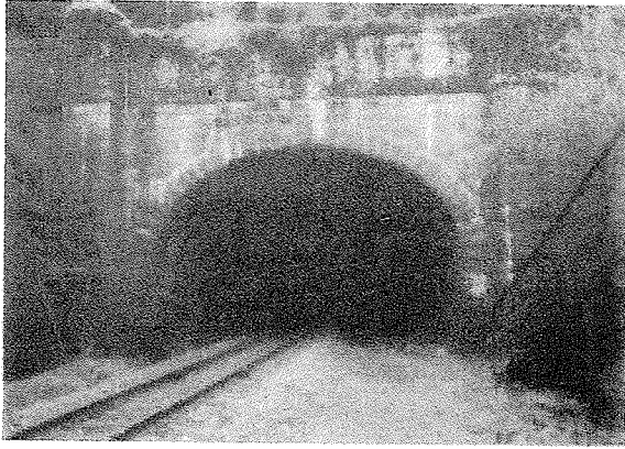
写真－1 金辺隧道入口抗門 (撮影：筆者、2000.3.6)
