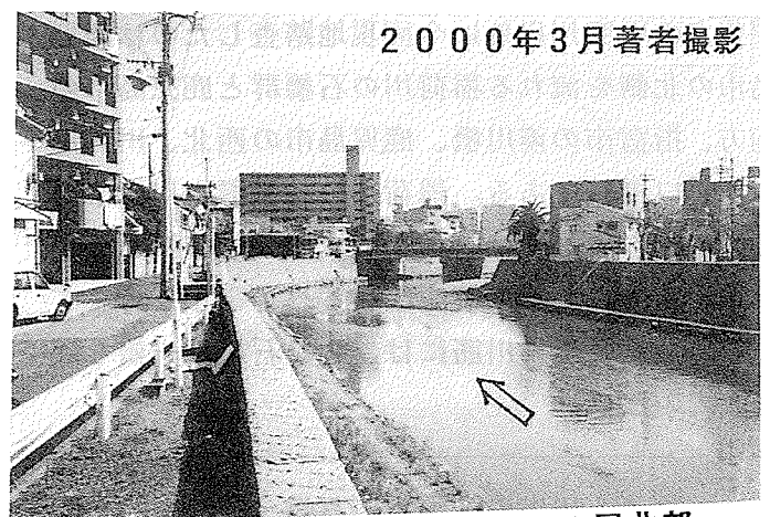
写真1 新上橋下流200mの屈曲部 （8・6水害で左岸から溢流）
