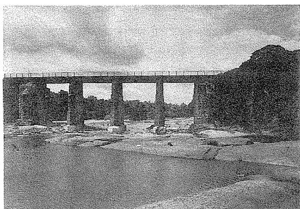
写真8 Daduru Oya Bridge (撮影：西、1999.8.)
