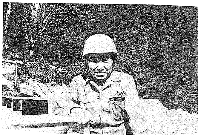
昭和38年 加治川発電所工事
