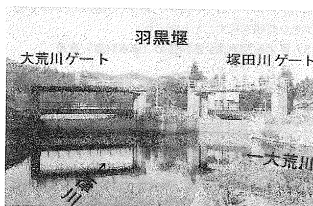
写真-3 羽黒堰(撮影:田辺、1999.10.10)
