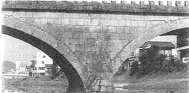
写真-6 解体前の布積み壁石(玉江橋第2橋脚部下流) (撮影: 著者 1994)
