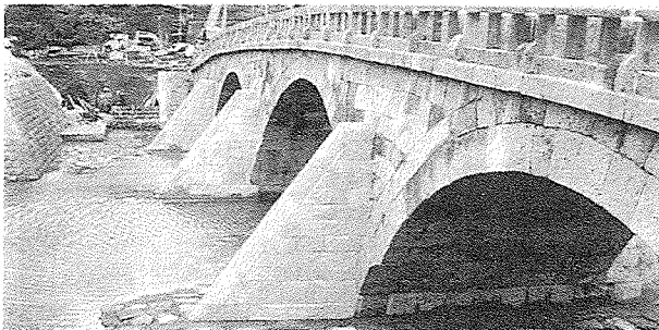
写真-8 全て新材で復元された水切石(玉江橋) (撮影: 著者 1998)
