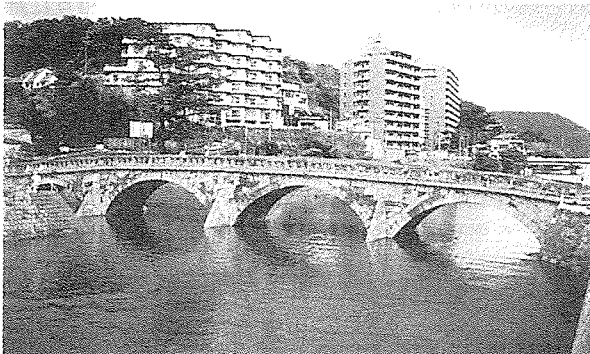
写真-18 復元された玉江橋 (撮影：著者 1999)
