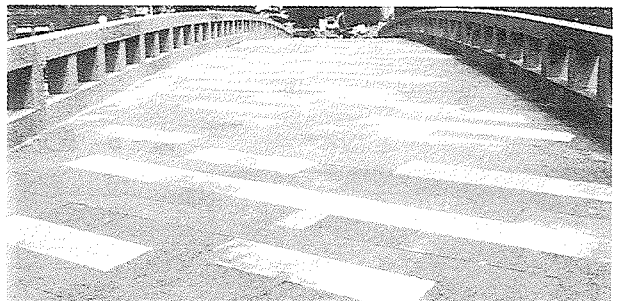
写真-10 整備された橋面工(高麗橋) (撮影: 著者 1998)
